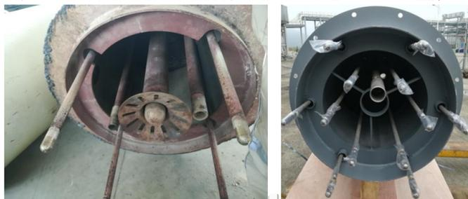
图1 原燃烧器火嘴布置图 图2 低氮燃烧器火嘴布置图
