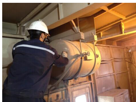
图1 固定式压力容器全面检验
