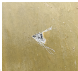
图5 附着力检测 不存在层间剥离现象
