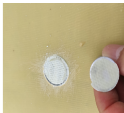
图4 粘结力检验 发现存在层间剥离现象
