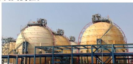
图1 球罐及管道涂层施工后半年内出现了褪色及变色的现象 鉴于以上情况，在进行防腐施工时，对于进场的材
