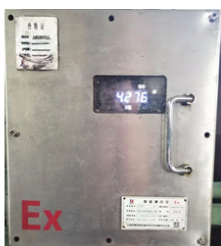
图2 接触式煤位计
