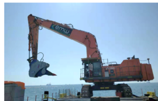
图 3 装配高频振动破岩机的挖泥船
