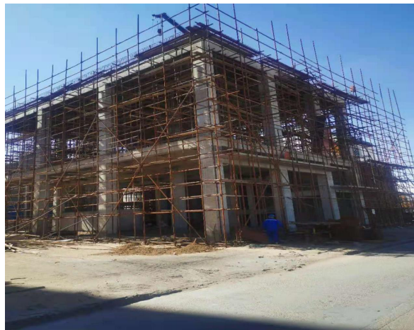
图2 施工中气化高密系统
