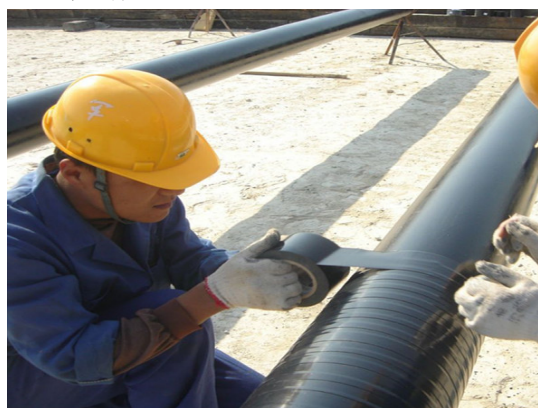
图3 天然气管道外部防腐
