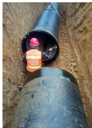
图4 天然气管道内部防腐
