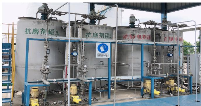
图 2 智能撬装式航煤定量加注系统实物图
