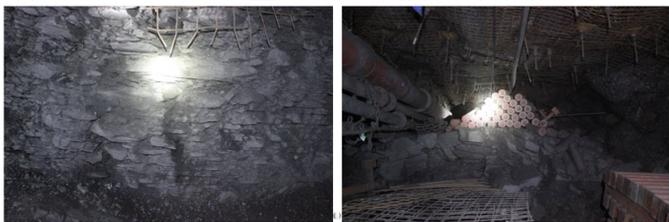
(a) 层状砂质泥岩底板 (b) 剧烈底鼓
