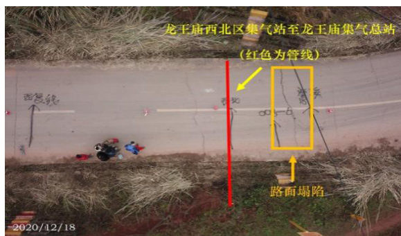
B. 管线上方路面塌陷
