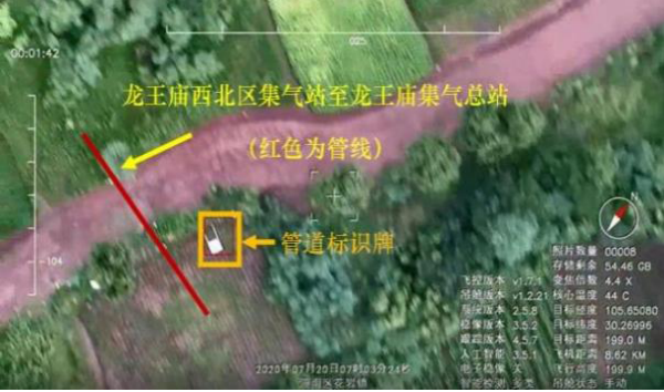
B. 发现管道标识牌倒塌
