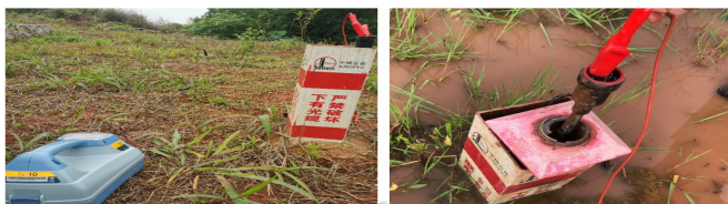
图6 光缆测试桩直连法检测现场设备连接图
