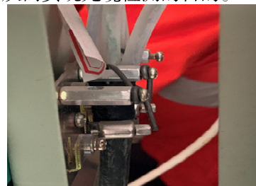
图7 阀室机柜内直连法检测现场图
