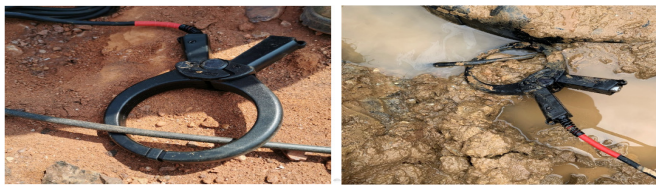
图3 夹钳法光缆检测现场图
