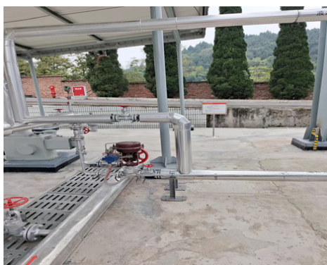
图1 变更后的上量泵进出口管线图
