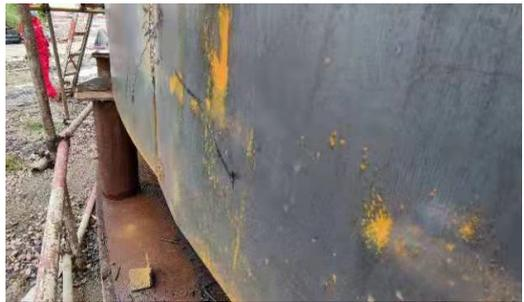
案例中，从材料验收预制与安装角度分析，方案执行的随意性，壁板的预制、辊板，壁板边缘弯曲不均、焊缝棱角度超标均是导致储罐变形要因，最终导致严重的质量问题，施工人员不得已将储罐下部壁板切割，重新订货、验收、预制、组对焊接，对经济、进度、质量、费用均产生了较大影响。
