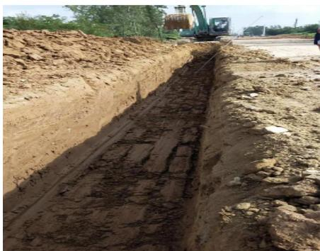
图 1 油气输送管道沟槽开挖示意图
