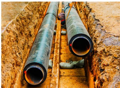
图 2 管墩布设示意图
