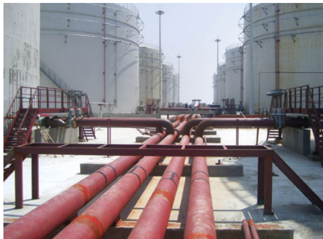
图1 石油化工管道安装
