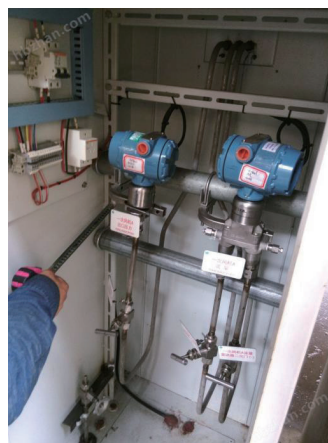
图 2 仪表伴热密封箱示意图
