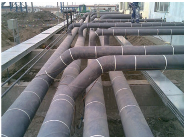
图 1 电伴热示意图
