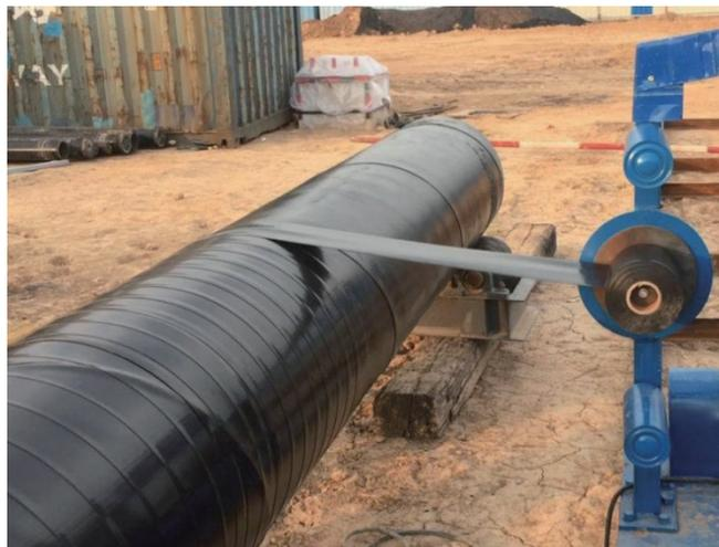
图 1 缠绕式石油化工管道用 3PE 防腐
