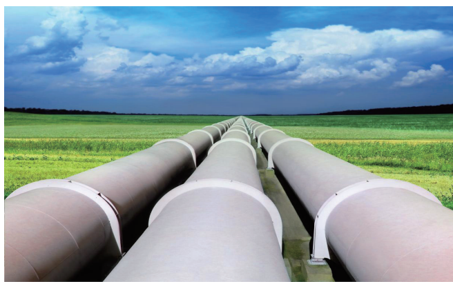
图 2 混氢天然气管道
