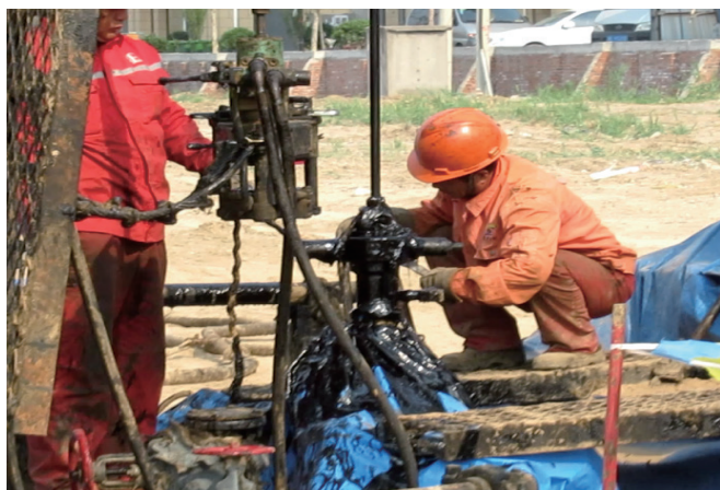
图1 传统施工井口与管杆在线清洗检测现场对比图
