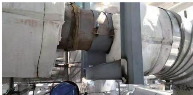
图5 现场增设滑动支撑图示
