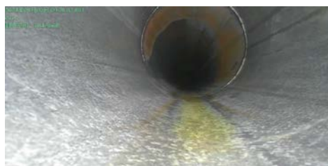
图 3- 串洗剂残留
