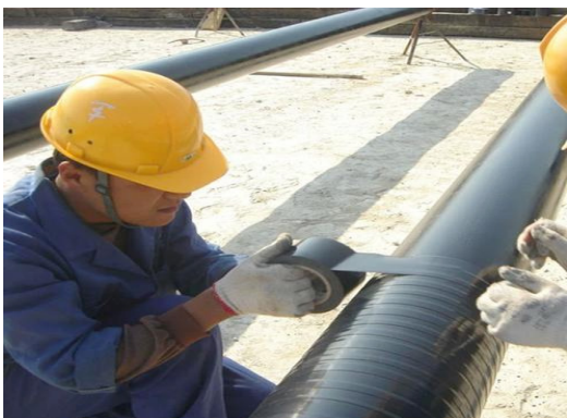
图1 在燃气管道外缠聚乙烯防腐胶带
