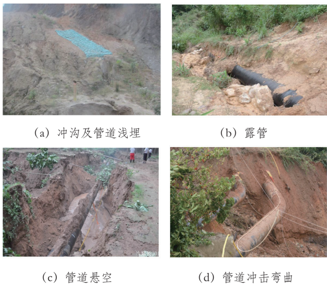
图 1 山区管道坡面水毁管道灾害危害管道模式现场照片
