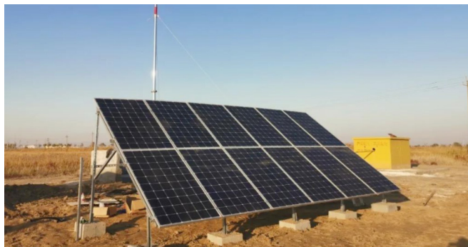
图 1 油田单井天然气管输加热太阳能供电系统
